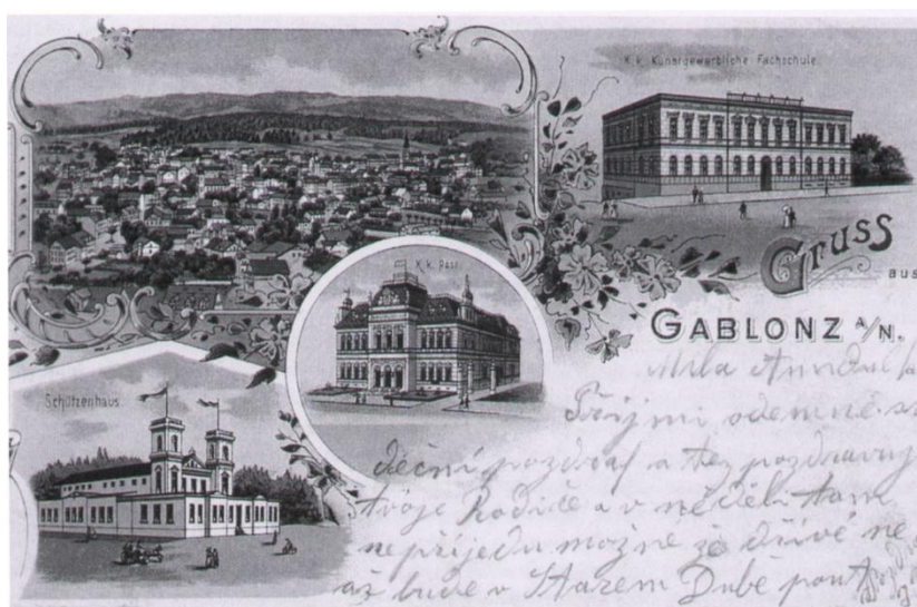
Obr. 5 – Pohled na Jablonce z roku 1895 s budovou školy v pravém horním rohu
